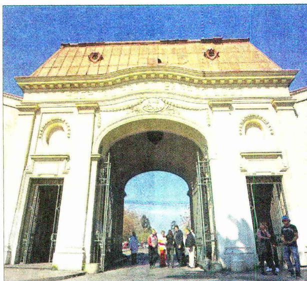
El arco del recinto ubicado en la comuna de San Miguel, tiene 105 años de antigüedad y se ocupó durante décadas como área de hospitalización.
