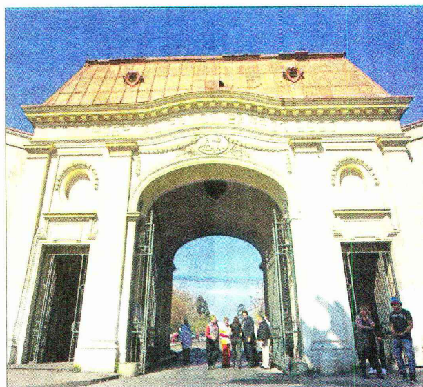
El arco del recinto ubicado en la comuna de San Miguel, tiene 105 años de antigüedad y se ocupó durante décadas como área de hospitalización.
