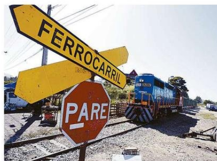
EL PASO NO CUENTA CON BARRERAS NI SEMÁFOROS, SÓLO SEÑALÉTICAS.
