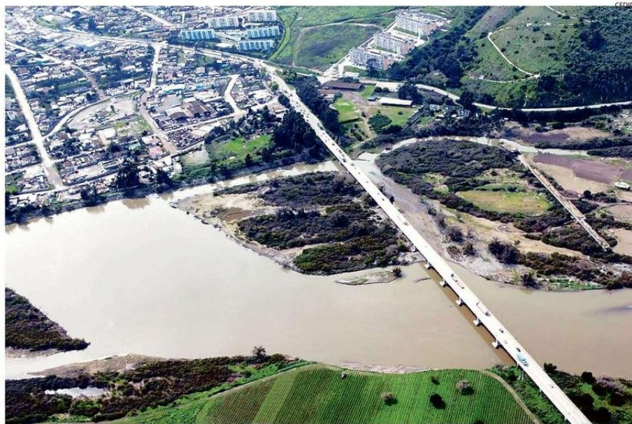
EL SEREMI DEL MOP DIJO QUE LA CONSTRUCCIÓN DEL NUEVO PUENTE ES UNO DE LOS PROYECTOS MÁS IMPORTANTES DE LA REGIÓN.
