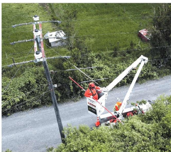
Brigadas de la compañía han concretado el mantenimiento de 38.000 kilómetros de redes en 2023, que equivale a dar la vuelta a la Tierra tres veces.
