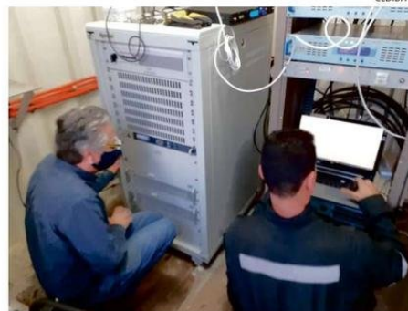
LA INSTALACIÓN DE EQUIPOS EN CALAN 2.
