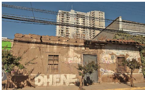
Otra fachada que se cae a pedazos en plena calle Zañartu.
