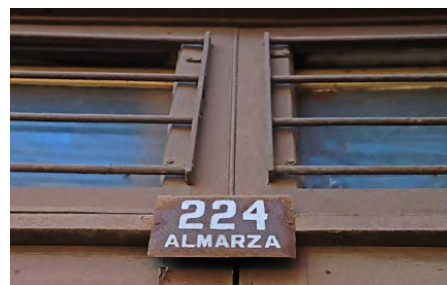
En calle Almarza las ventanas de una antigua casa 224 fueron selladas con fuertes barrotes de hierro oxidados.
