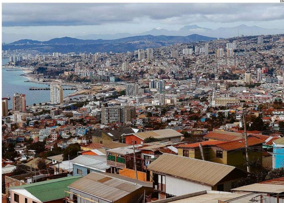
HAY UN TEMA CON LOS PLANES REGULADORES COMUNALES Y LOS INCENDIOS, COMO EL ACCESO A CIERTOS LUGARES PARA EQUIPOS DE EMERGENCIA.
