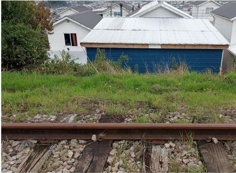
ALGUNAS CASAS DE LOS RESIDENTES DE ESTE BARRIO PUERTOVARINO ESTÁN A SÓLO DOS O TRES METROS DE LA LÍNEA DEL TREN.
