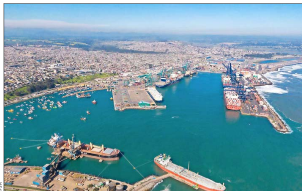
Las primeras obras consisten en la construcción de un molo de unos cuatro kilómetros de extensión y el dragado en el área de la futura dársena.
