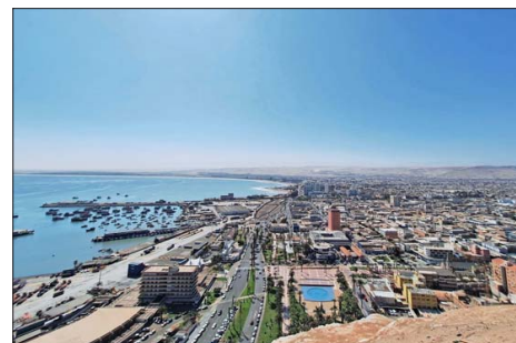
RADIO URBANO. — Las obras que forman parte de la indagatoria incluyen una ruta de acceso a un valle agrícola, calles, alcantarillado, entre otros.
