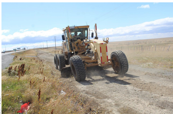
Comenzó el trabajo de maquinaria pesada en la Ruta 9.
