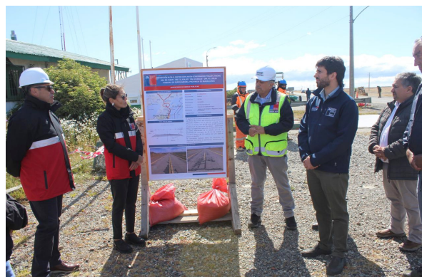
Autoridades inspeccionaron el inicio de las obras.
