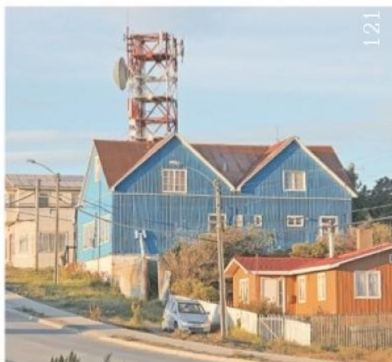
Ante una interrupción de Internet, hoy Porvenir no posee sistema de redundancia, aunque sí tiene un "Plan B", que es una conexión por microondas (foto), con una muy mínima capacidad de ancho de banda.
