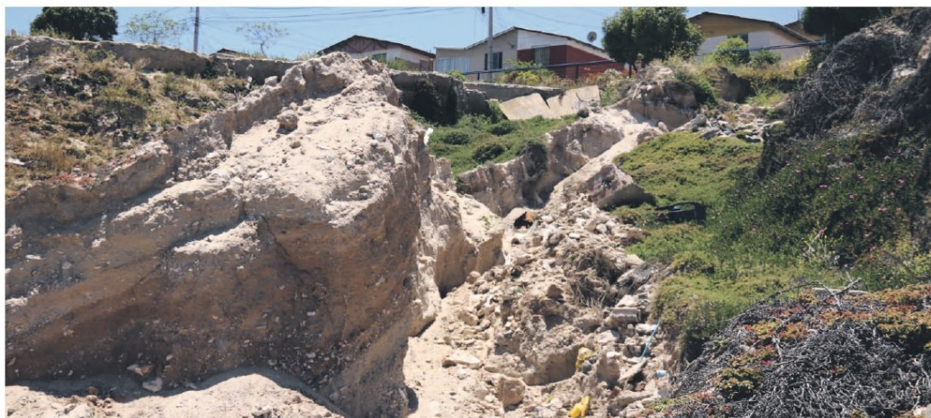
Los dueños de las viviendas aledañas al socavón dicen tener temor de que el barranco avance con cada lluvia y sismo, lo que podría llevarlos a perder sus casas.
