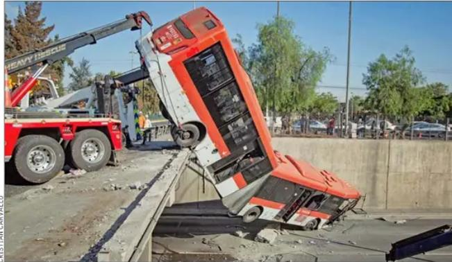
**Trabajos.** Fue necesario demoler parte de la barrera de contención para facilitar las maniobras de retiro del bus y permitir el despeje del área.
