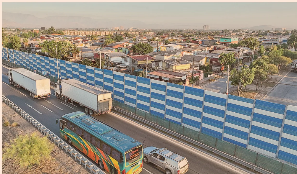
Proyecto en Autopista Vespucio Sur, el más grande de este tipo realizado hasta ahora en el país, considera 16,4 km de barreras acústicas bi-absorbentes de 4, 5 y 6 metros de altura, con paneles de fabricación italiana.
