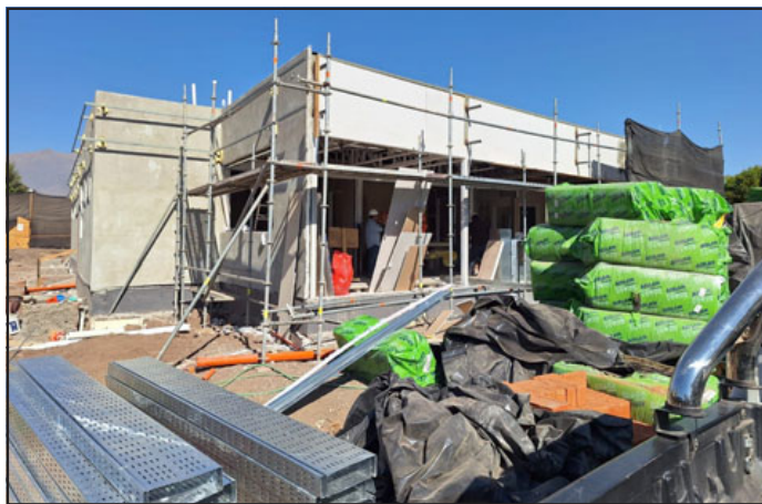
Un 40% de avance presentan las obras de construcción del SAR del Cesfam Segismundo Iturra.
