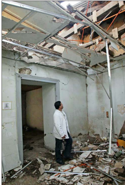
En el terremoto de 2010 muchos hospitales de la zona central sufrieron daños estructurales. Una investigación está analizando cómo los aisladores sísmicos ayudan a que el edificio y su equipamiento tengan menos consecuencias.
