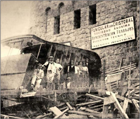
PRIMEROS DÍAS.— La infraestructura fue inaugurada en 1925, tras más de un año de trabajos a cargo del ingeniero italiano Ernesto Bozo.
