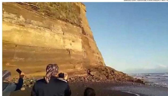
EL MAR AVANZA HACIA TIERRA FIRME, EN LA IMAGEN, DESPRENDIMIENTOS DEL CERRO MAULE.
