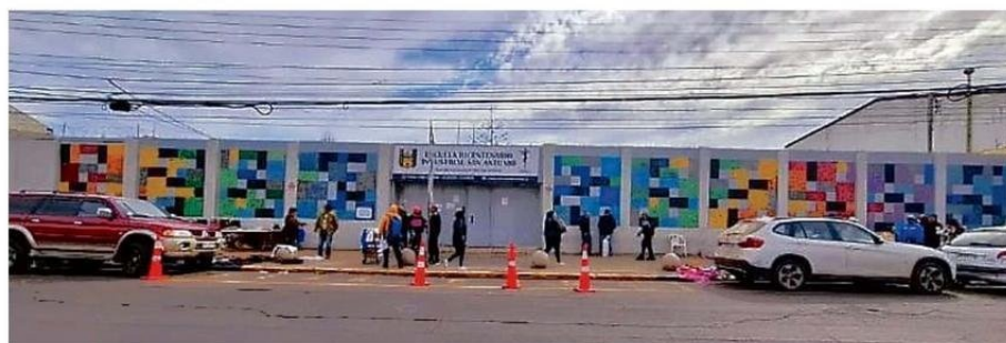
UNA VISTA PANORÁMICA DE LA NUEVA FACHADA DE LA EISA.
