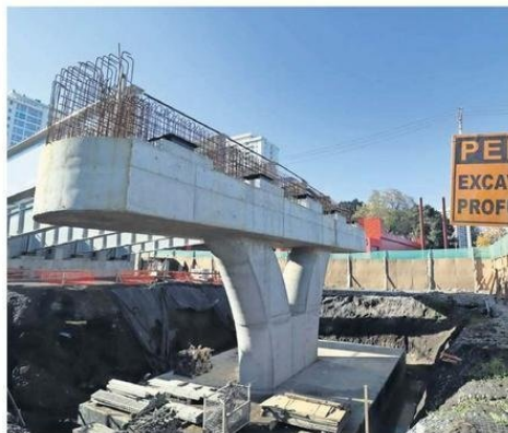
Autórrumores destacaron el avance de las obras.
