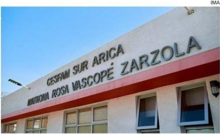
DISPOSITIVO DE SALUD FUNCIONARA ADOSADO AL CESFAM SUR.
