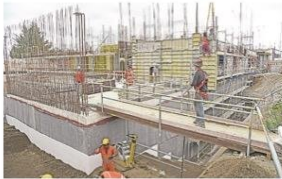
En el rubro de la construcción predominan la contratación de carpinteros y jornales. En la foto, la obra del nuevo consultorio 18 de Septiembre.
