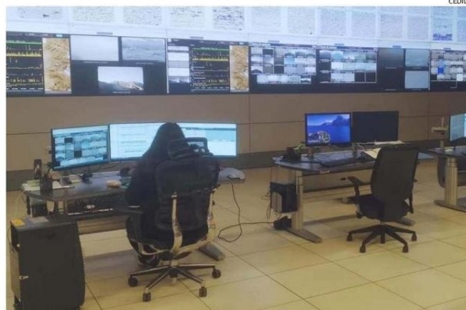
LA SALA DE MONITOREO DEL OVDAS REALIZA UNA LABOR 24/7 EN TIEMPO REAL.
