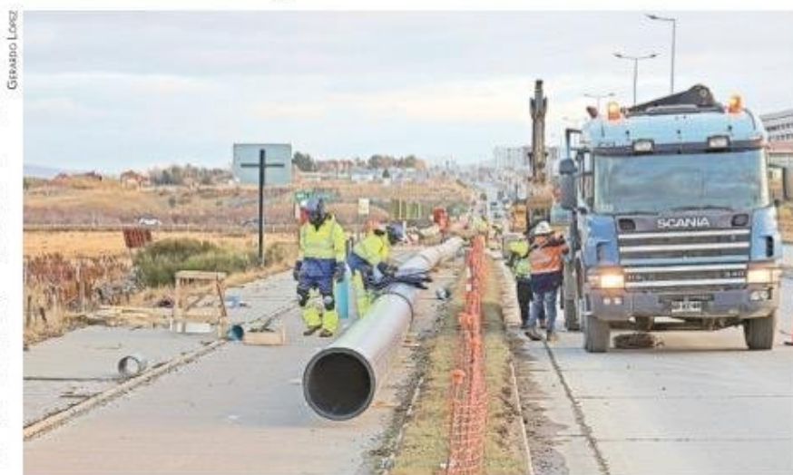
Las obras de instalación de la tubería para evacuar las aguas servidas por la Avenida Presidente Frei llevan un 10 por ciento de avance.
