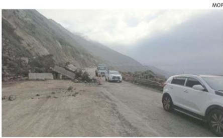
TRAS EL DERRUMBE, SE DESPEJÓ UNA VÍA, LUEGO TODA LA RUTA.
