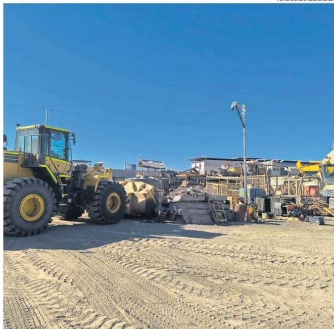
OCUPANTES NO CUENTAN CON NINGUNA AUTORIZACIÓN PARA ESTAR INSTALADO EN EL ÁREA.
