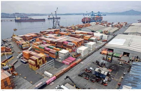
El terminal posee dos grúas STS y conexión con rutas viales y ferroviarias.
