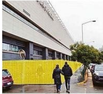
TRABAJOS EN LA FACHADA.
