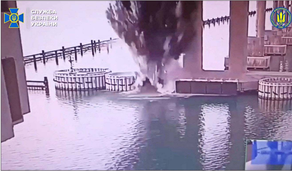
EL SERVICIO UCRANIANO de Seguridad divulgó estas imágenes —que no pudieron ser verificadas de forma independiente— de lo que describió como la explosión que dañó ayer el puente Kerch en Crimea.
