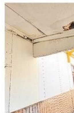
Daño por filtración en el Liceo Bicentenario Luis Cruz Martínez. En la izquierda la imagen de 2023 y a la derecha la correspondiente a 2024.
