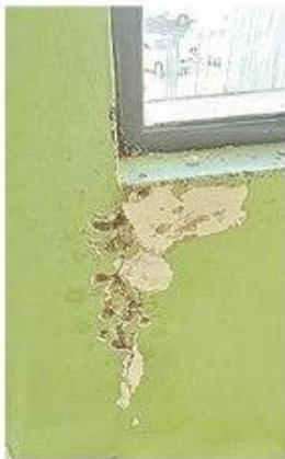
Paredes dañadas por filtración en la Escuela Bernardo O'Higgins. En la izquierda la imagen de 2023 y a la derecha la correspondiente a 2024.
