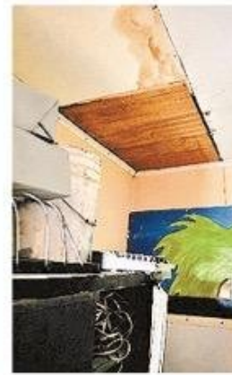
Daño en cielo por filtración en la Escuela Capitán Juan Ladrillero. En la izquierda la imagen de 2023 y a la derecha la correspondiente a 2024.
