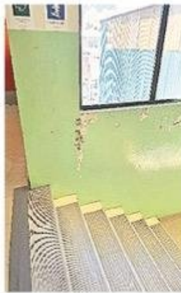
Paredes dañadas por filtración en la Escuela Bernardo O'Higgins. En la izquierda la imagen de 2023 y a la derecha la correspondiente a 2024.
