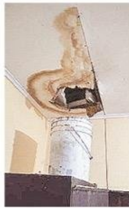
Daño en cielo por filtración en la Escuela Capitán Juan Ladrillero. En la izquierda la imagen de 2023 y a la derecha la correspondiente a 2024.
