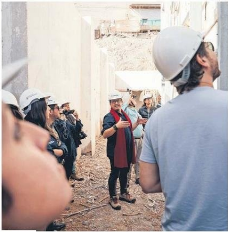
CARCEL TIENE RIESGO DE COLAPSO.
