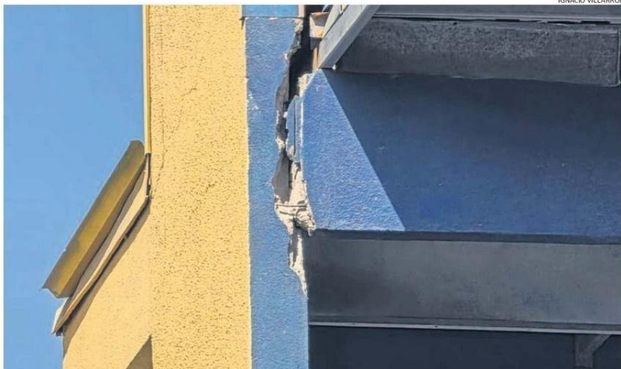
IMPORTANTES DAÑOS EN EL REVESTIMIENTO.
