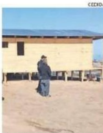
INSTALARON CASA PREFABRICADA.
