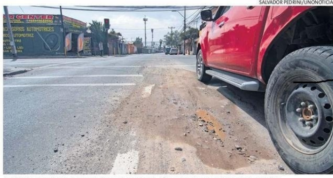
EL PAVIMENTO SE DETERIORÓ EN MENOS DE UN AÑO POR FILTRACIONES EN EL SECTOR.
