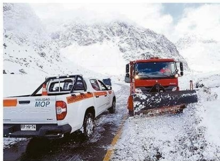
MOP HA REALIZADO DIVERSOS TRABAJOS DE MITIGACIÓN PREVENTIVOS.
