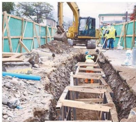
DESDE EL PRÓXIMO LUNES LOS TRABAJOS PARTEN EN CALLE TERESA.
