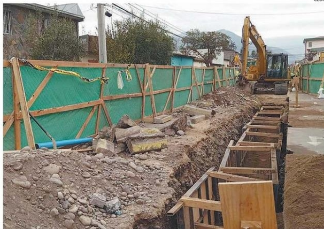
HABRÁ RECAMBIO DE 352 METROS DE TUBERÍA, ADEMÁS DE LA RENOVACIÓN DE UNIONES DOMICILIARIAS
