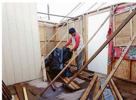
LA PRECARIIDAD DE ALGUNAS VIVIENDAS DA CUENTA DE LAS URGENCIAS.
