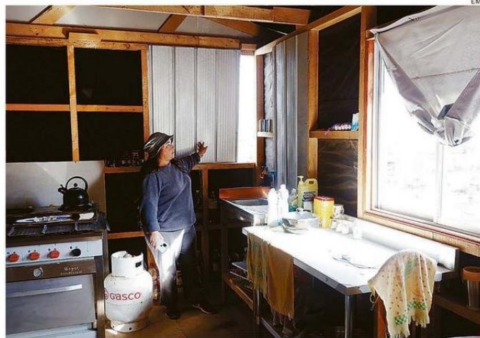
MYRIAM DÍAZ PASÓ LA LLUVIA SIN VENTANAS: NO CUENTA CON RECURSOS PARA PODER TERMINAR SU CASA.
