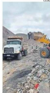
TRABAJOS EN LA CADENA.
