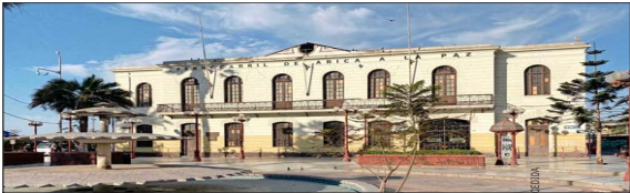
Deterioro. La fachada del edificio, uno de los más tradicionales de esa ciudad, junto a una pileta alledaña han sido vandalizados en los últimos años.
