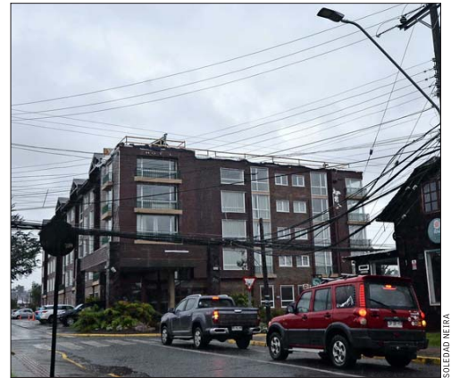
ABIERTO. — En infraestructura turística, el mayor daño lo recibió el techo del Hotel Solace (en la foto), que aún está con trabajos pero funcionando.
