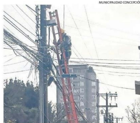
BRIGADAS ELÉCTRICAS TRABAJANDO EN LAS CALLES PENQUITAS.
