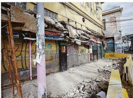
EL USO DE UNA RETROEXCAVADORA AGRAVÓ EL ESTADO DEL FRONTS.
