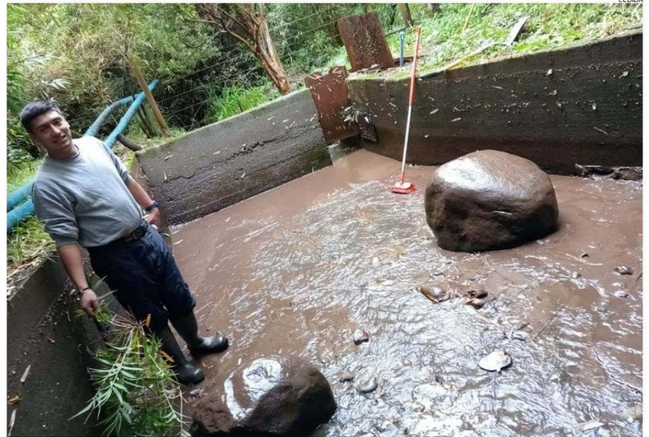
LAS PISCINAS DEL APR SE LLENAN DE BARRO Y SEDIMENTO CON LAS PRIMERAS LLUVIAS, MATERIAL QUE ES ARRASTRADO DESDE LA VERTIENTE.
