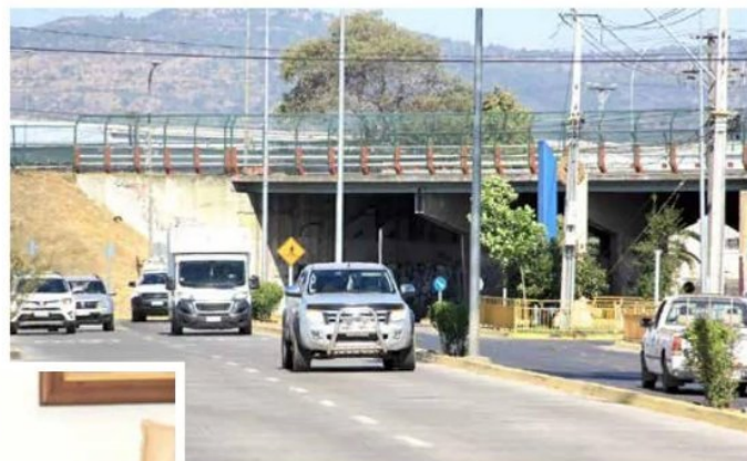
Los pórticos lectores de patentes se instalarán en avenidas de salida y acceso a Curicó.
