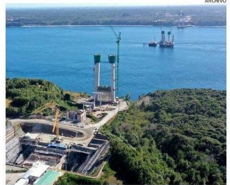
AYER EN LA TARDE LOS TRABAJADORES DECIDIERON PARAR LAS OBRAS.
