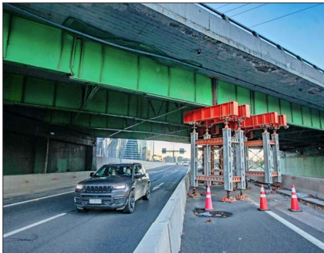
INFRAESTRUCTURA. — Fue construido a inicios de la década de 1970, por lo que resistió los terremotos de 1985 y 2010. No está concesionado, por lo que su conservación y mantención dependen exclusivamente del MOP.
