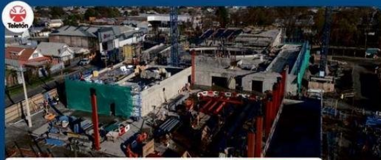
Está en marcha la construcción del Instituto Teletón de Ñuble .
