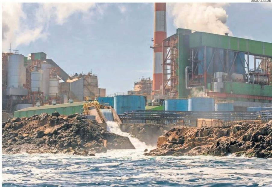
EL AGUA UTILIZADA PARA LA REFRIGERACIÓN POR EL COMPLEJO ENERGÉTICO DE GUACOLDA SE DEVUELVE AL MAR.
