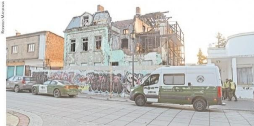
La Casa de los Derechos Humanos de Avenida Colón presenta una ruinoso condición.
